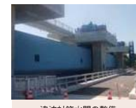
津波対策水門の整備
