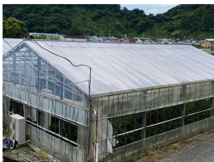
図1 遮熱剤塗布したハウス
