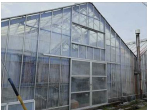
図1 遮熱剤を塗布したハウス
