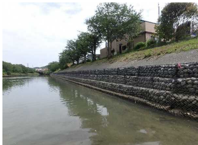
水害対策のための河川改修
