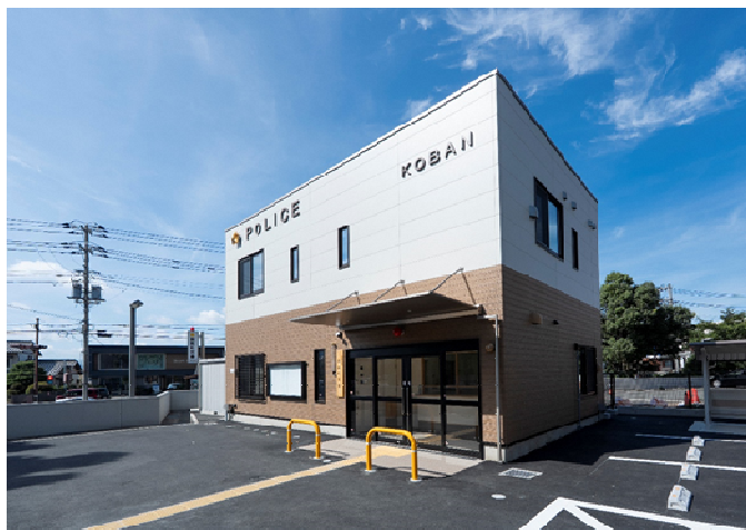
県有建築物のZEB化
