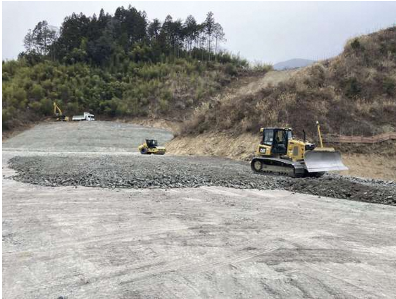
写真 2 他工区における施工状況
