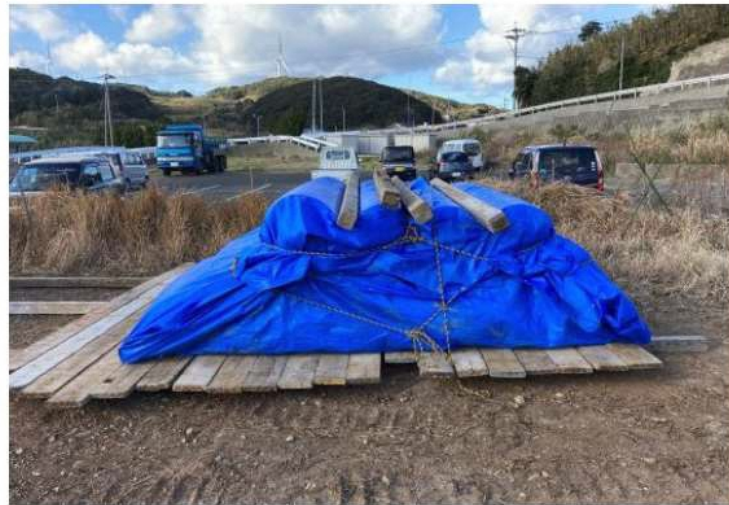
図 5 2 ブルーシートによる養生イメージ
