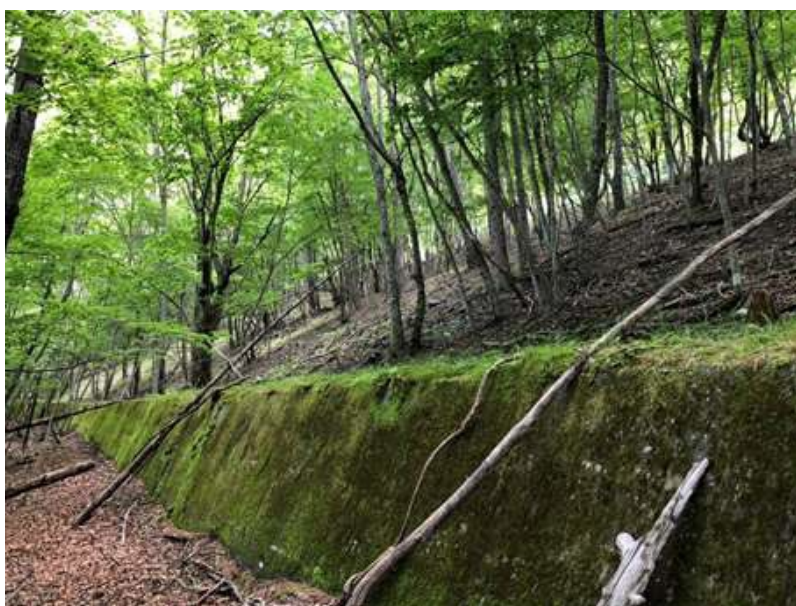
写真 1 藤島発生土置き場現地状況
