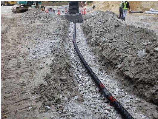
写真 3 水平排水工及び縦排水工の例
