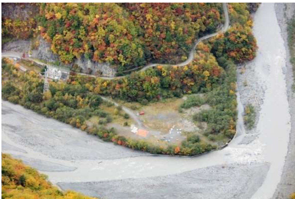
写真 ６ 剝石発生土置き場現地状況
