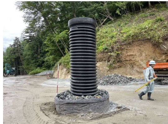
写真 3 水平排水工及び縦排水工の例
