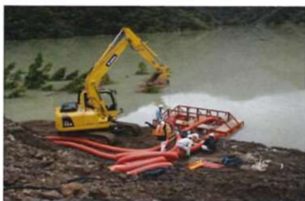
排水ポンプの設置
