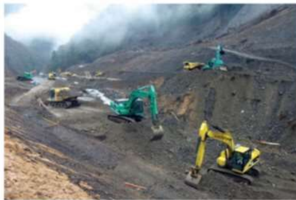
重機を用いた崩土の撤去
