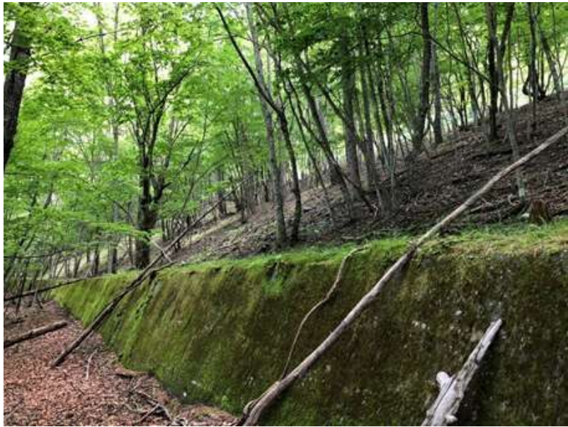
写真 5 藤島発生土置き場現地状況
