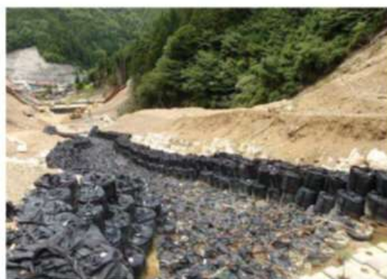
仮設排水路の整備
