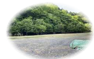
▲藤島発生土置き場
