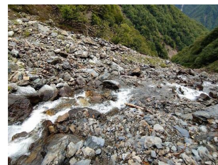
図33 調査地点の状況(蛇抜沢)
