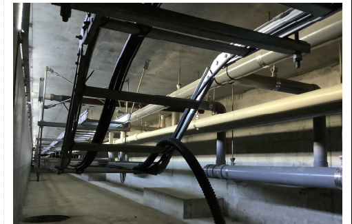
メンテナンス通路
