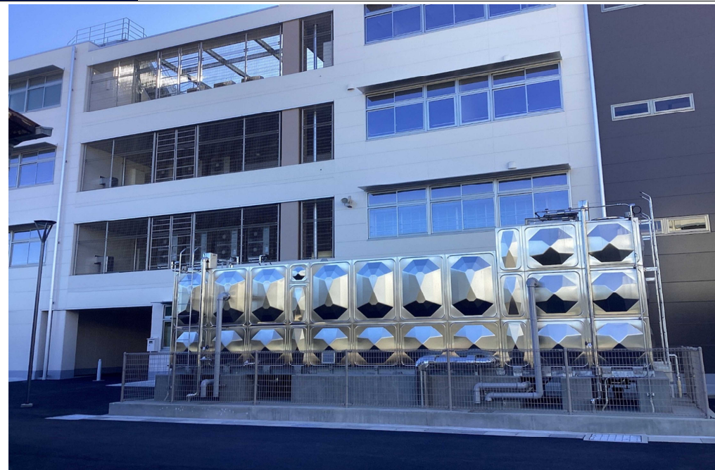
特別教室棟北面（受水槽・設備スペース）
