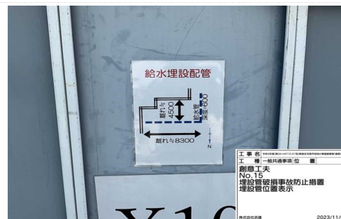
仮囲いへの埋設配管位置図の掲示
