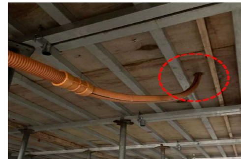
仮設水抜きパイプの設置
