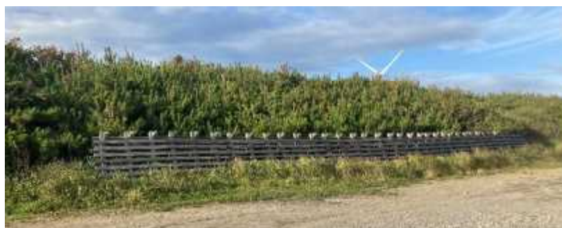
図 1 設置された防風工
