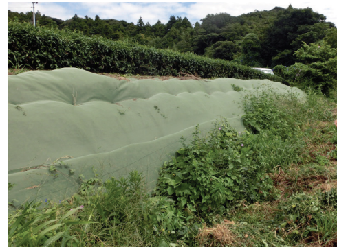
半透過性の素材を使った防草シートで法面を覆う。現在試験中で、2年間イノシシによる掘り返しはない
