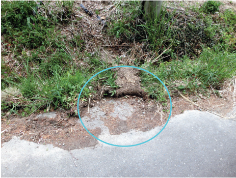
アスファルトの上に土が堆積し、その上に生えた雑草をめくるようにして掘り返されている
