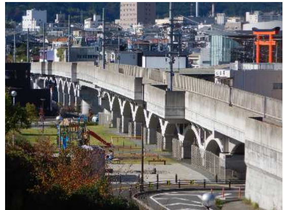
(例) 富士宮高架におけるプレキャスト桁の採用状況
