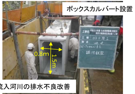
拡幅改修による排水能力の増加
