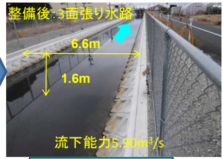
米津排水路 整備後
