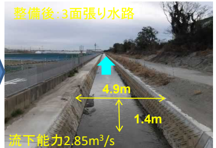
屋島川 整備後
