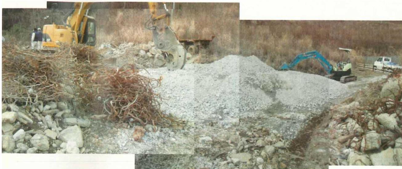
がれきの分別・破砕作業等が行われ、がれきの山は幾分減少し、代わりに碎石、鉄筋の山が大きくなっている
