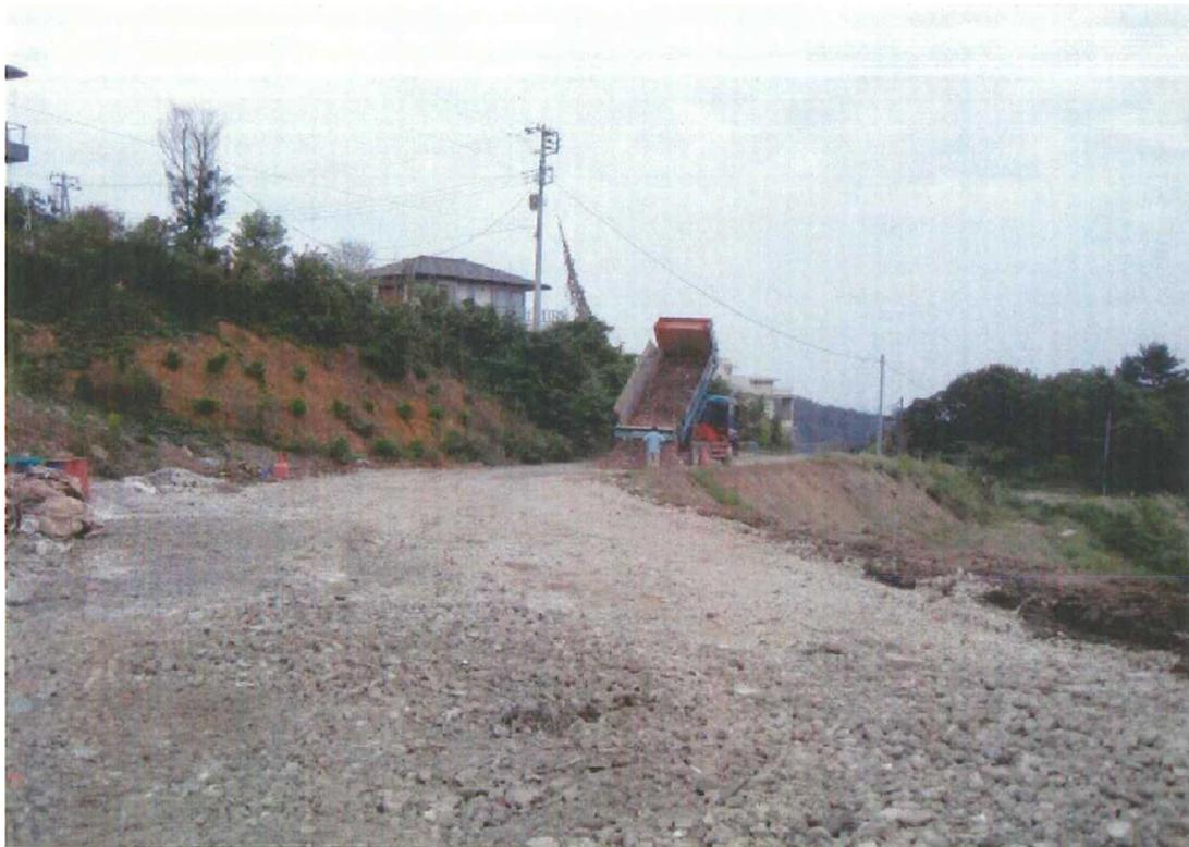
相模ナンバーのダンプ車両が①区域の進入路に「土、砕かれた瓦、陶器類で粒度がふぞろいのもの、ガラスくず、鉄筋、廃プラが混ざったもの」を下ろす
