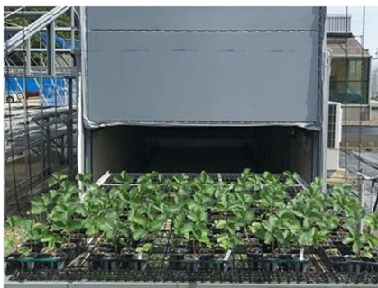
図3 短日夜冷設備
