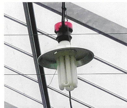
図2 UV-B電球型蛍光灯 写真は畝面と口金の距離が1~1.5mの場合に用いる平皿型反射板タイプ
