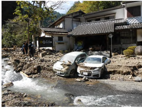
土石流の状況 (静岡市葵区油山)
