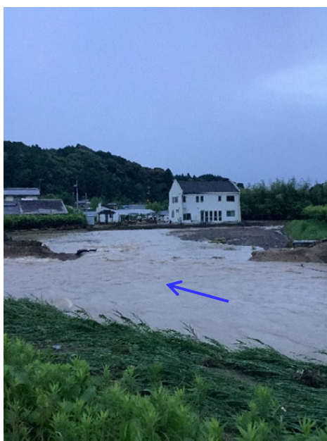
二級河川敷地川の破堤 (磐田市敷地)
