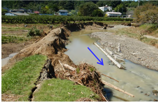
二級河川敷地川の破堤 (磐田市敷地)
