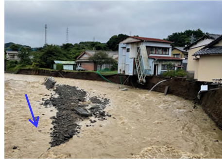
二級河川庵原川の護岸決壊 (静岡市清水区庵原町)
