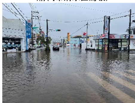
一級河川沼川流域の浸水状況 (沼津市原)
