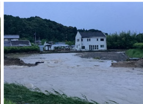
二級河川敷地川の破堤（磐田市敷地）
