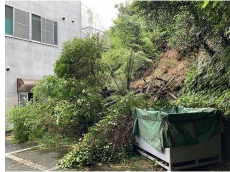
がけ崩れの状況 (湖西市鷺津)
