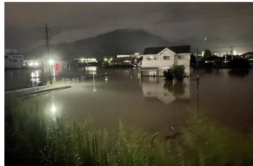
二級河川石脇川流域の浸水状況 (焼津市岡当目)
