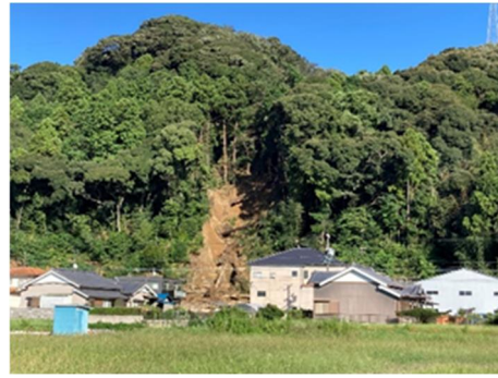
がけ崩れの状況 (磐田市平松)
