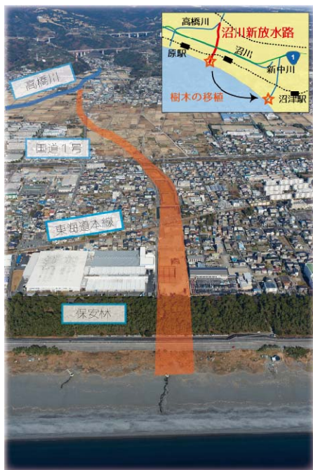
▲沼川新放水路工事現場の様子
