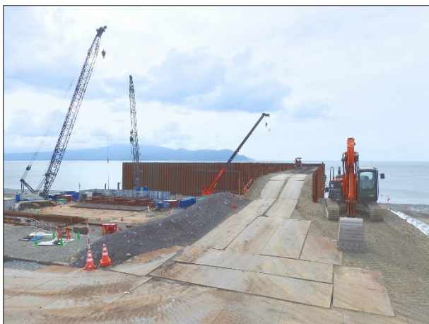
海岸部工事 仮設防潮堤の施工状況
