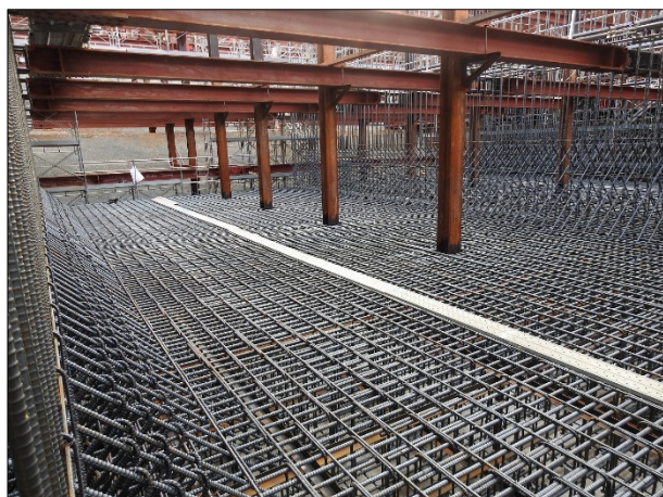
函体工事 底部鉄筋組立完了
