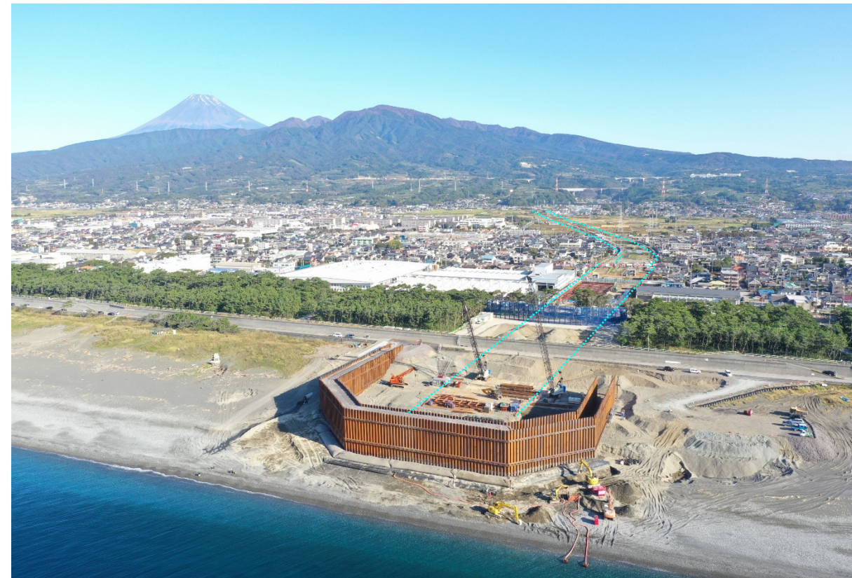
海岸部仮設防潮堤の施工状況 令和2年11月時点
