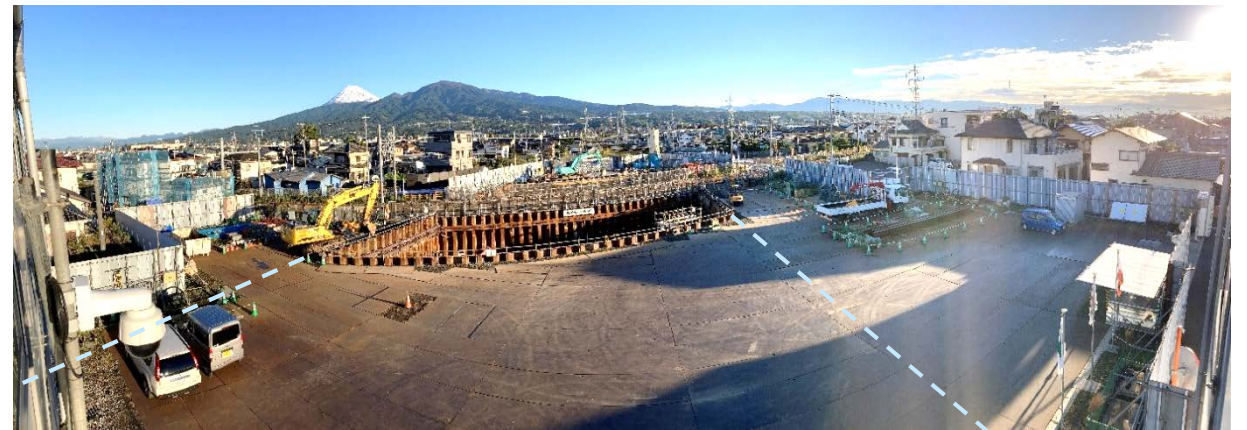
J R 交差部南側ヤード内作業状況（上流を望む）
