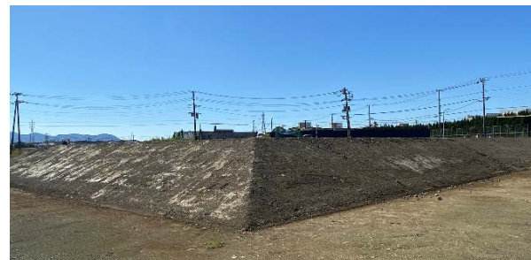
令和4年度盛土施工箇所
