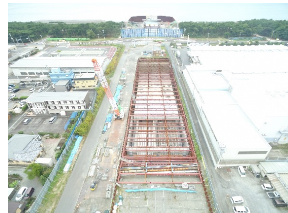
上流側から海側を望む（令和4年9月末撮影）
