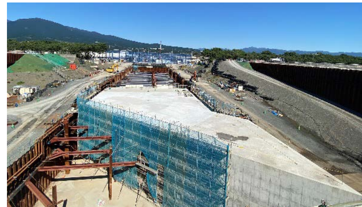
海側から上流を望む（令和4年9月末撮影）
