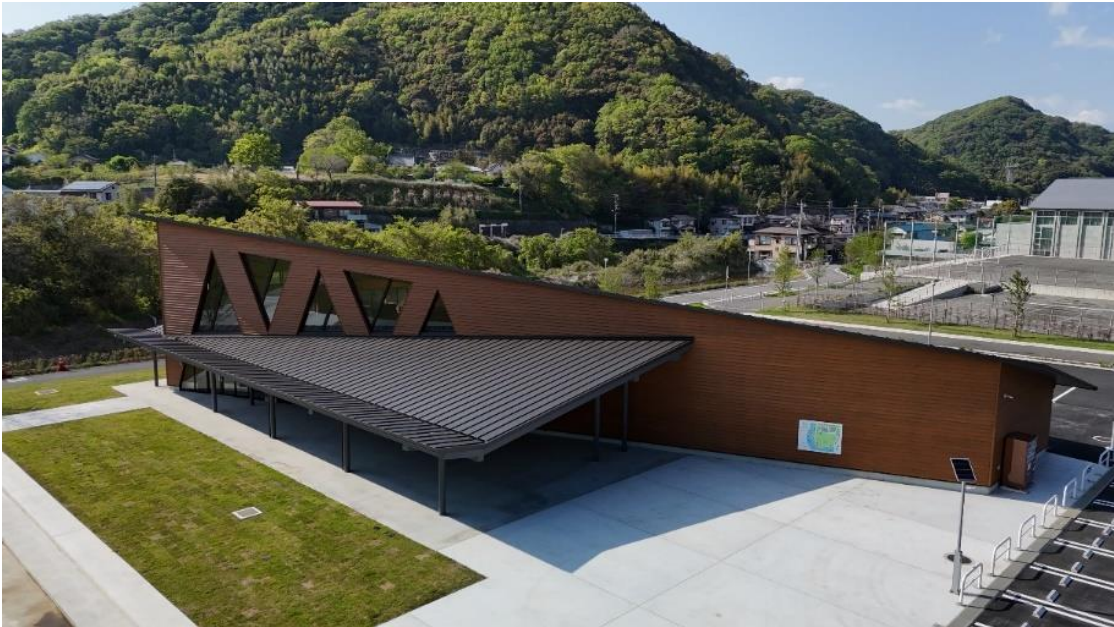
【写真】 建物外観
