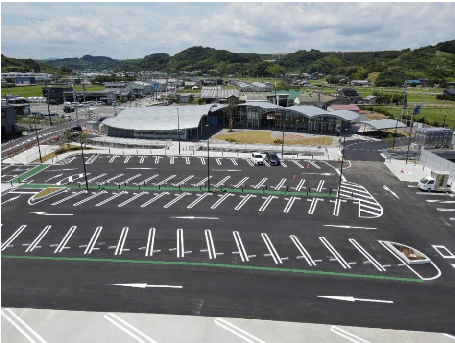
【写真】 建物外観
