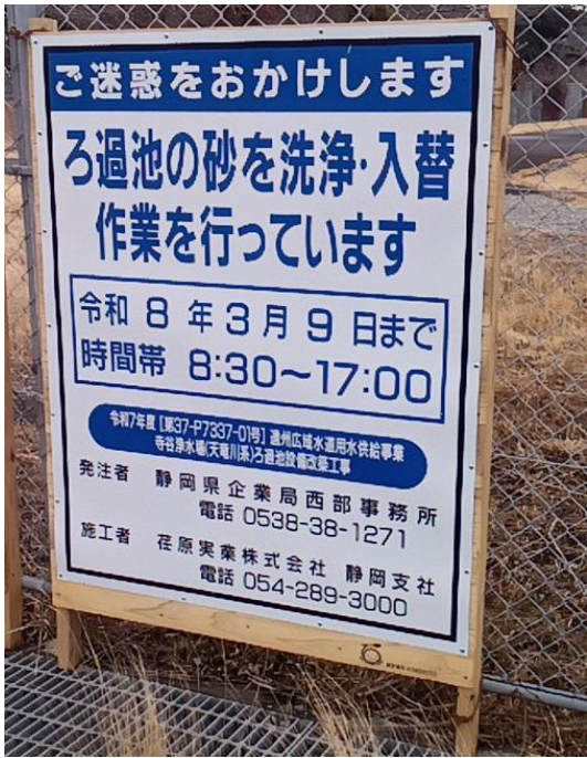
【写真】 工事案内看板①設置状況
