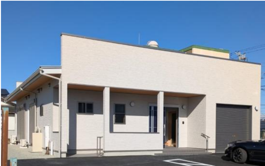
【写真】 建物外観
