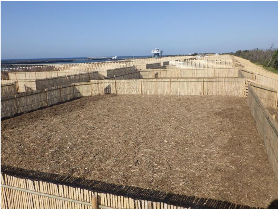
【写真】マルチング敷均し
