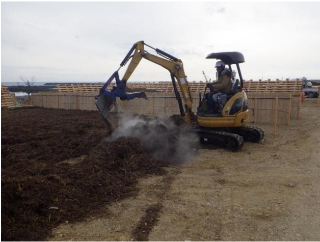
【写真】施工状況
