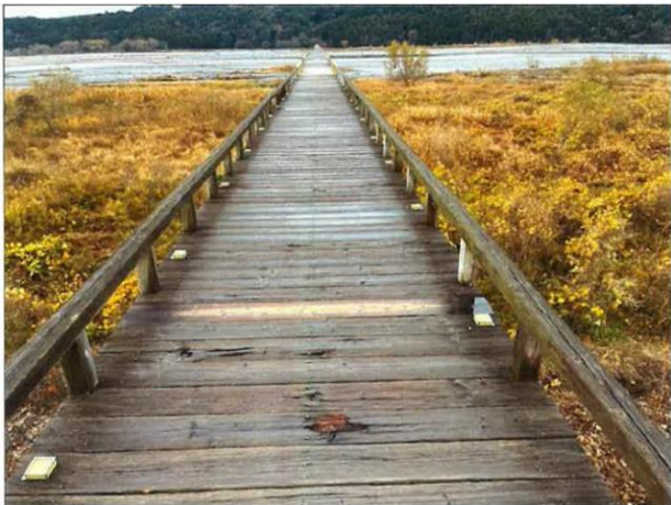
【写真】上部工（束柱・笠木・敷板）
