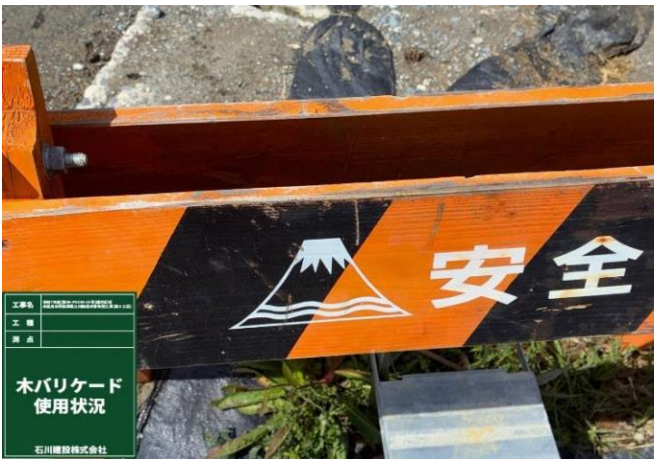
【写真】 木製バリアード使用状況
