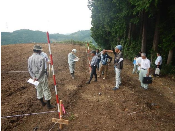
【写真】 道路境界杭の設置状況
