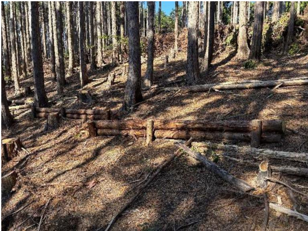
【写真】 現地発生材を利用した簡易木製構造物を設置
