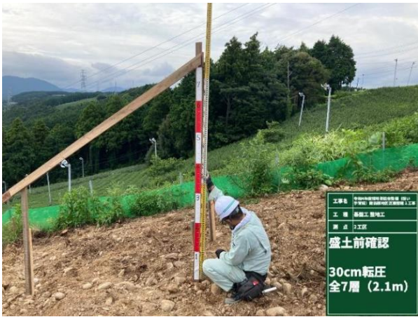
【写真】 法面丁張の設置状況
