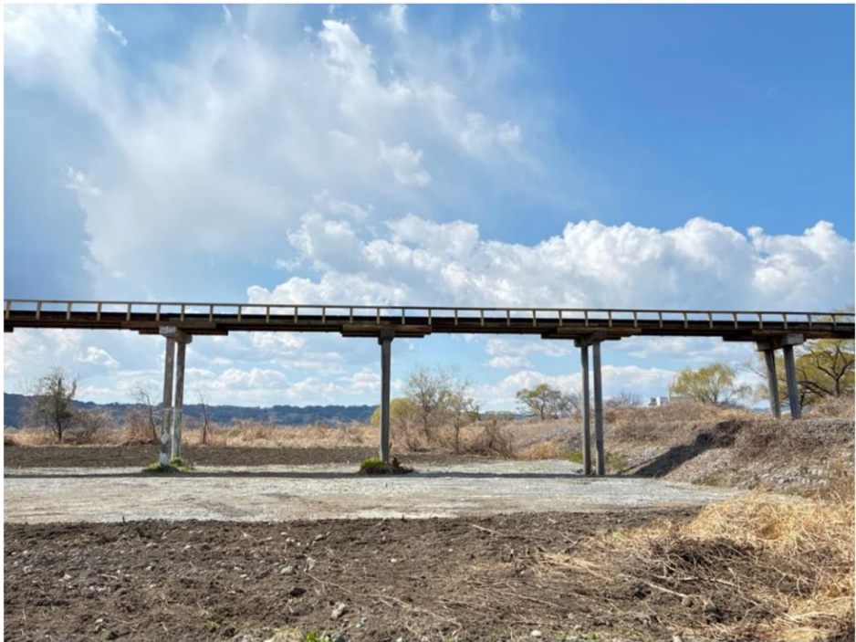
【写真】上部工（束柱・笠木・敷板）
