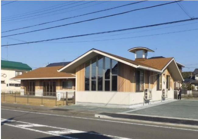
【写真】建物外観
