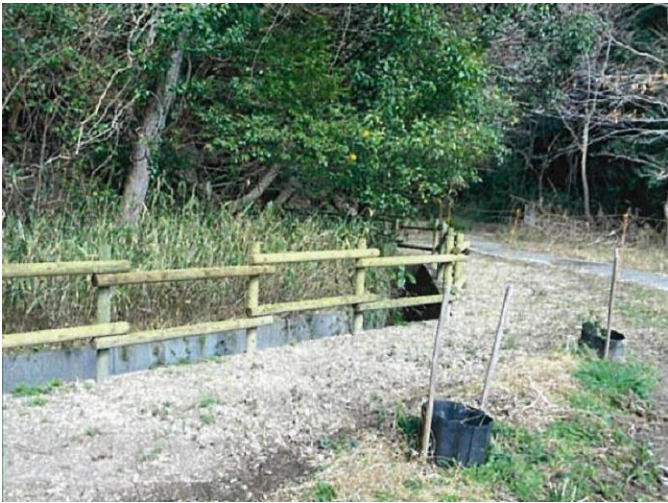
【写真】 転落防止柵設置状況
