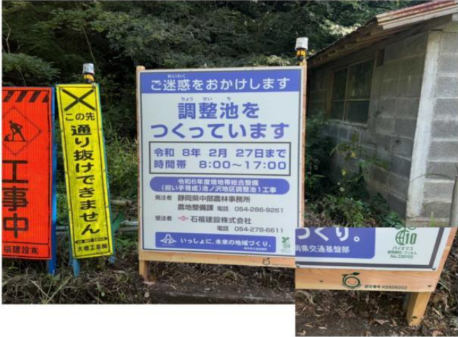
【写真】 工事看板
