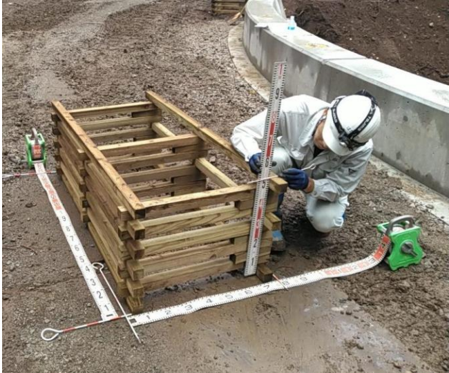
【写真(上・下)】 材料及び施工状況
