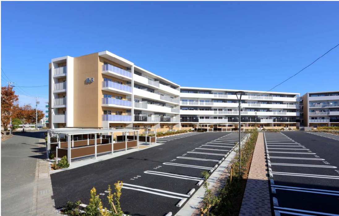
【写真】 建物外観
