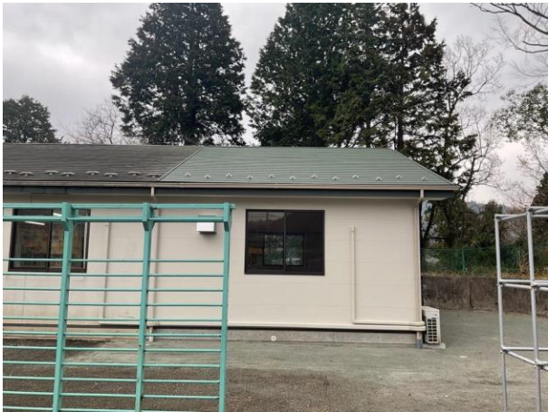
【写真】増築部分
