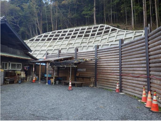
【写真】 仮設防護柵工完了
