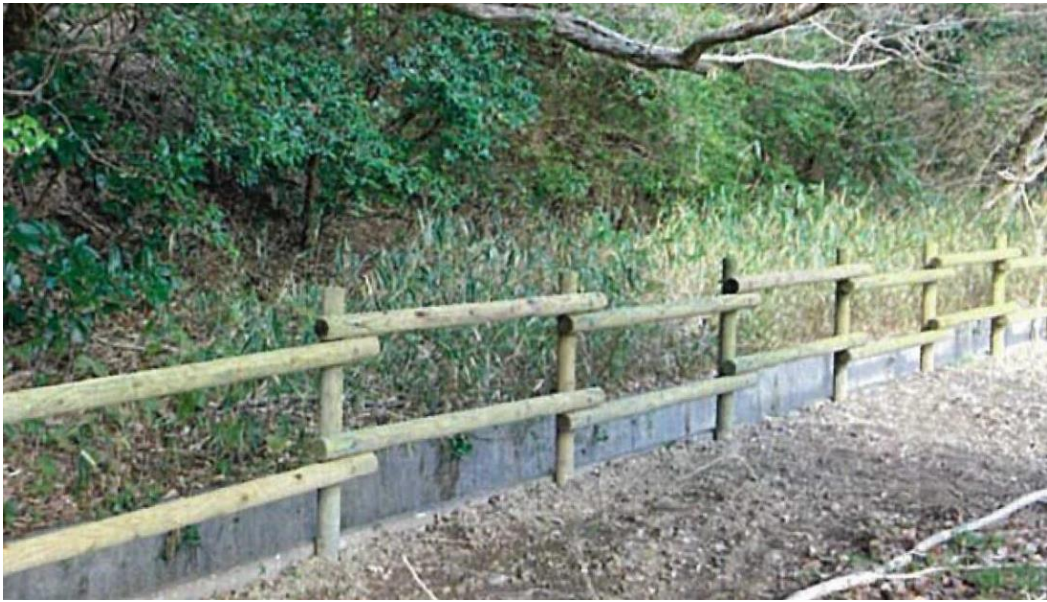
【写真】 転落防止柵設置状況
