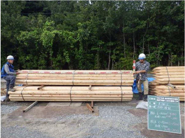
【写真】 材料検収状況
