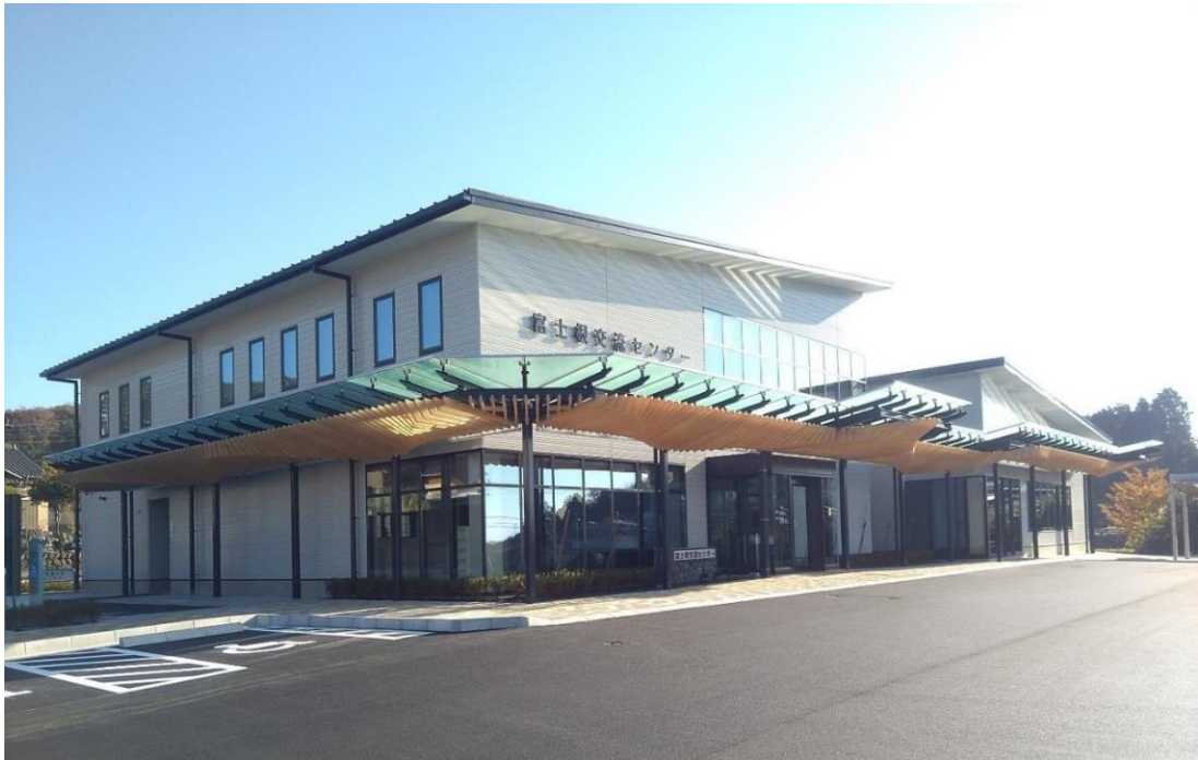
【写真】建物外観
