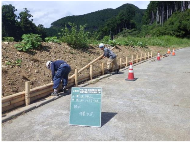
【写真】 施工状況
