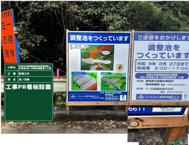
【写真】 工事看板
