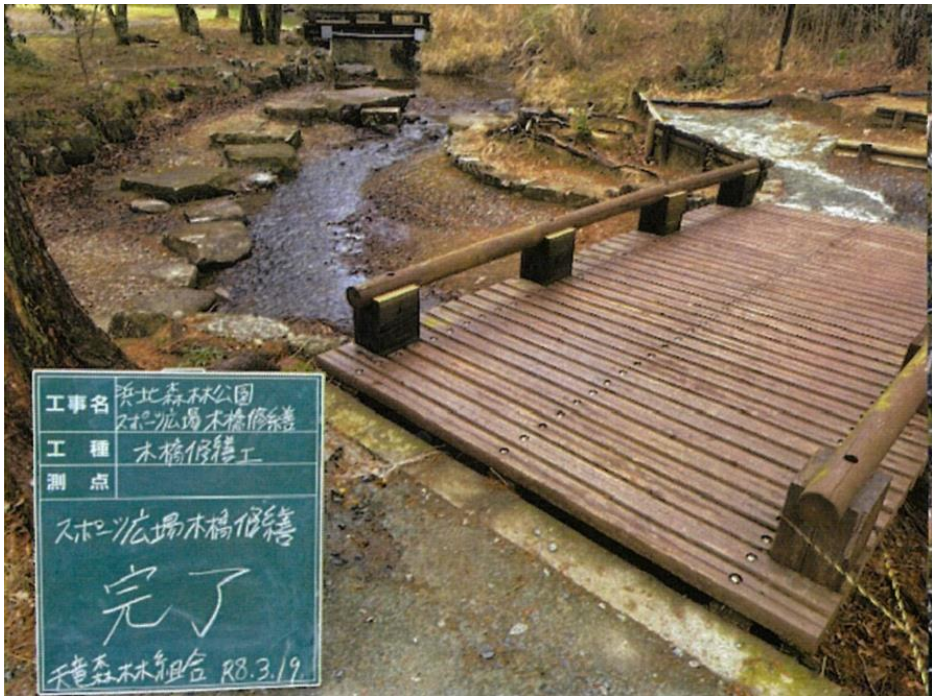
【写真】 木橋柵修繕(遠景)
