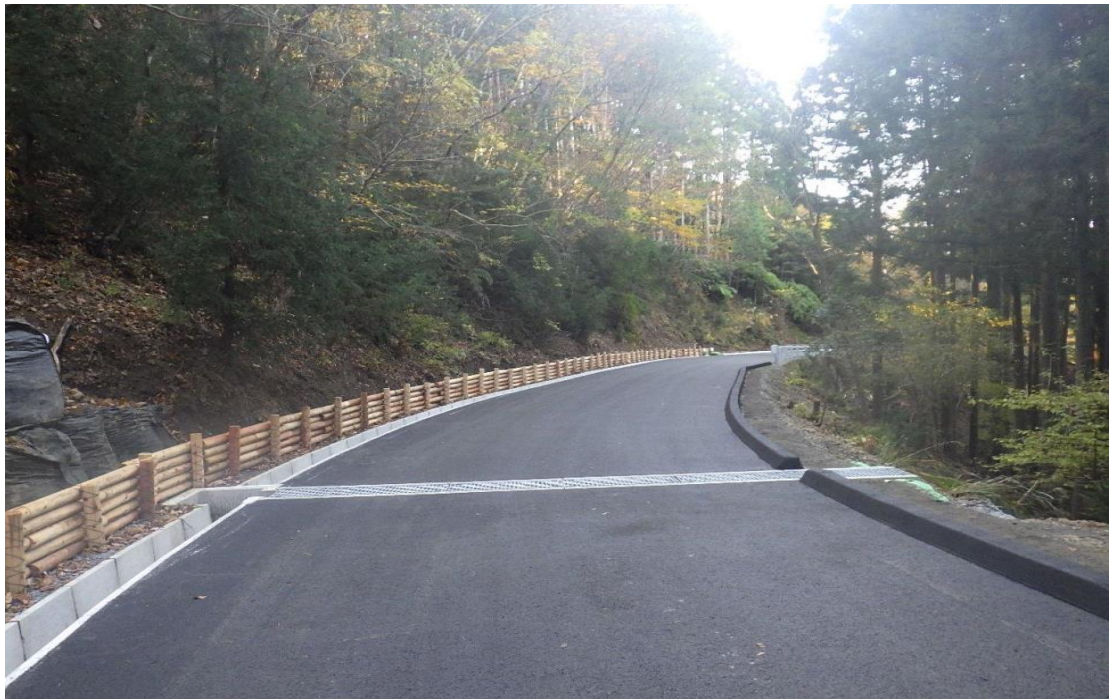
【遠景】木柵工(杭木・横木)
