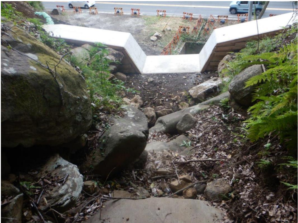
【写真】 上流残存型枠
