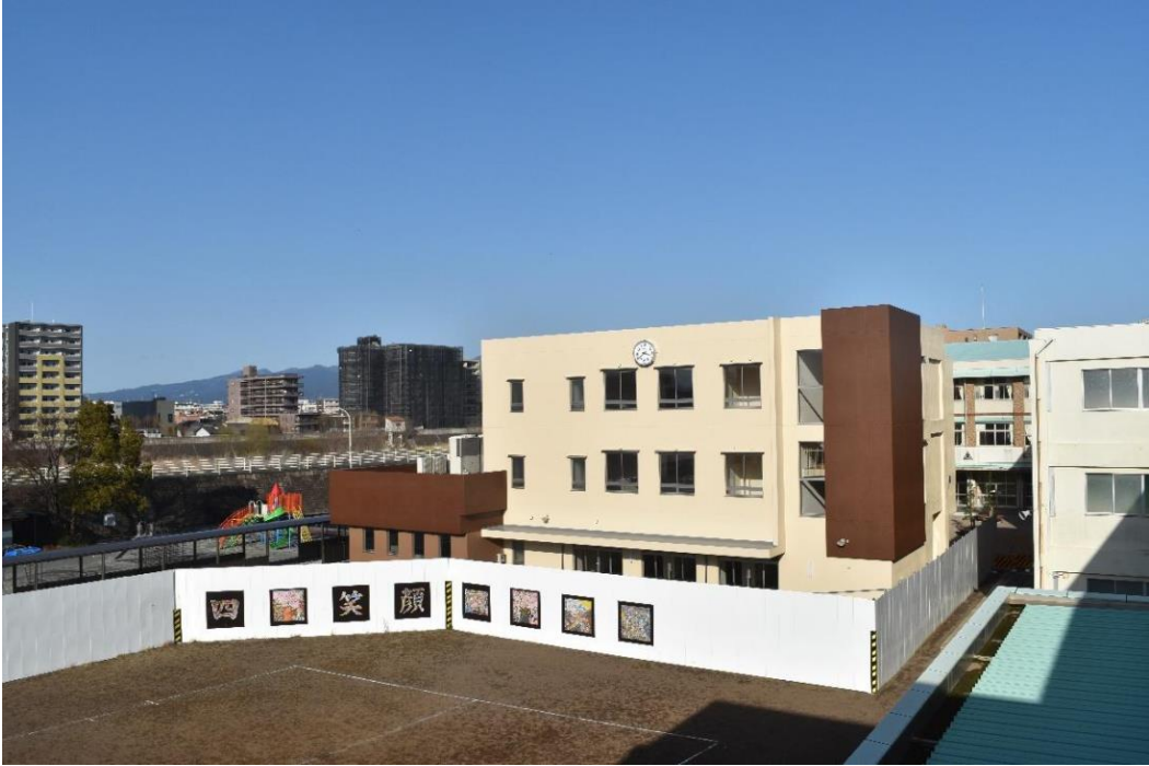
【写真】建物外観
