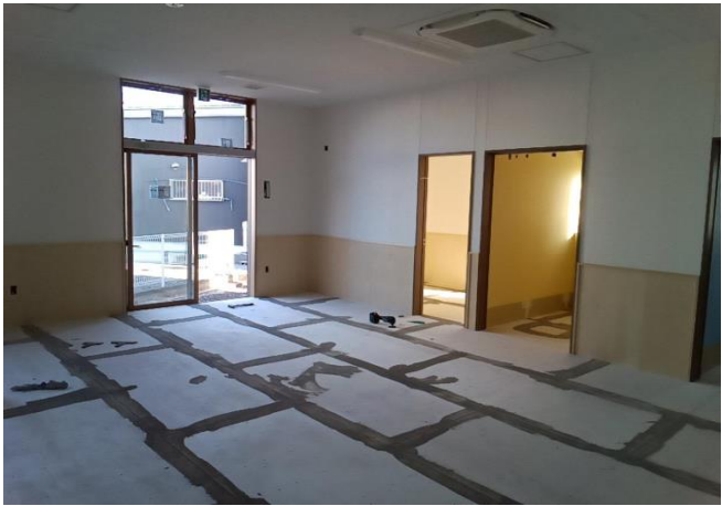
【写真】腰壁仕上
