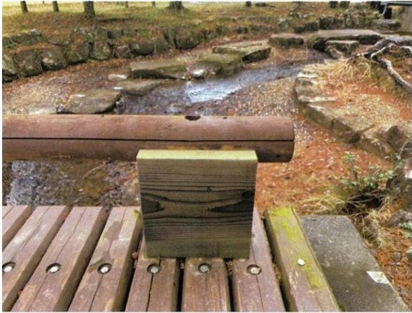
【写真】 木橋柵修繕(近景)
