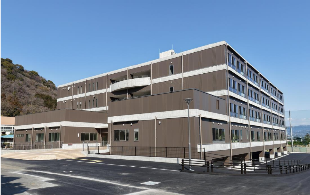
【写真】建物外観
