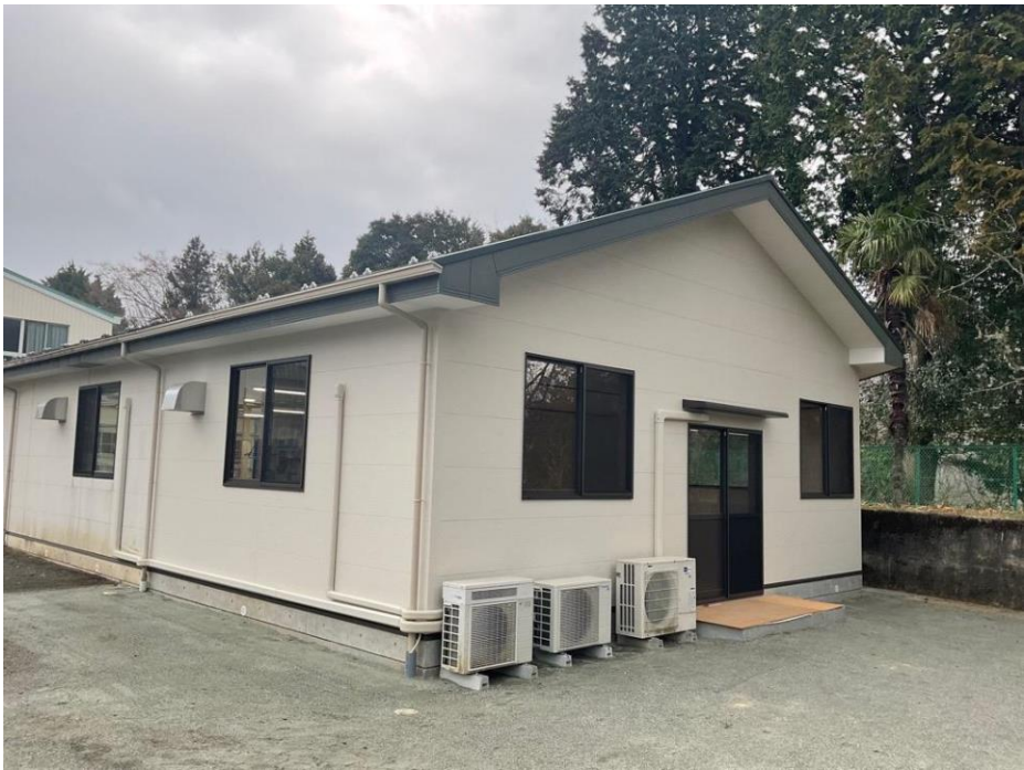
【写真】建物外観
