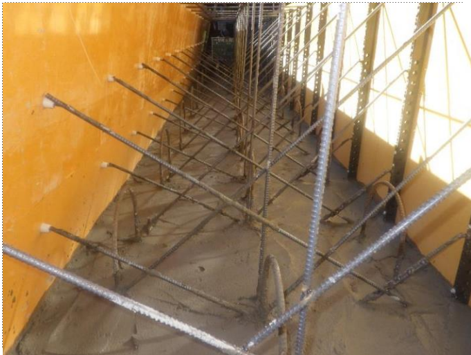
【写真】 型枠設置状況
