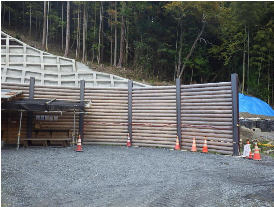
【写真】 仮設防護柵工完了
