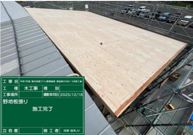
【写真】 屋根 野地板
