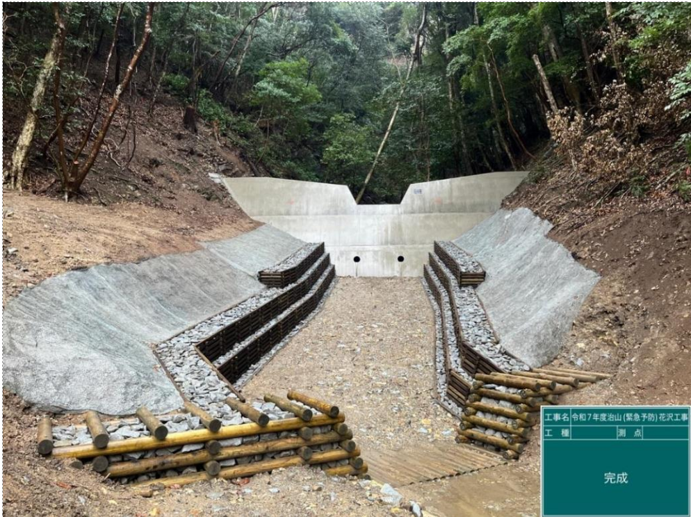
【写真】 木製校倉式ダム工 完成
