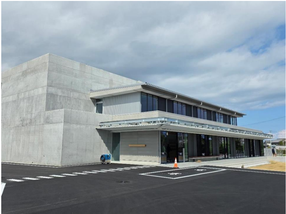
【写真】 建物外観
