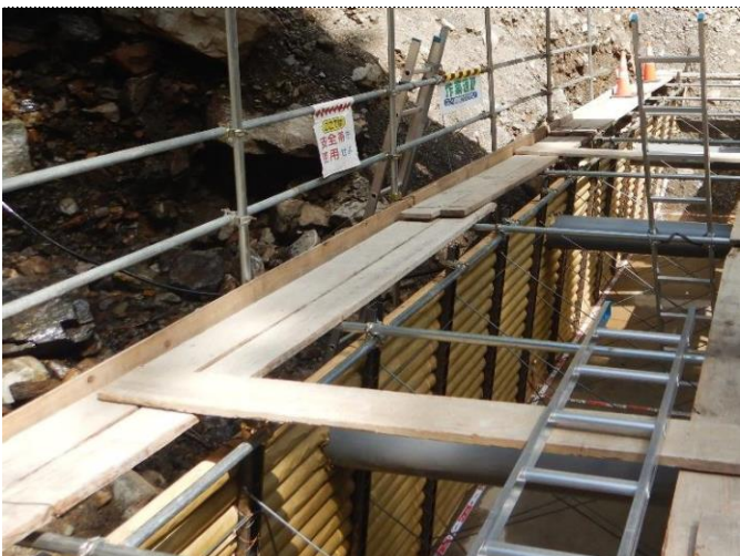
【写真】 型枠組立の様子
