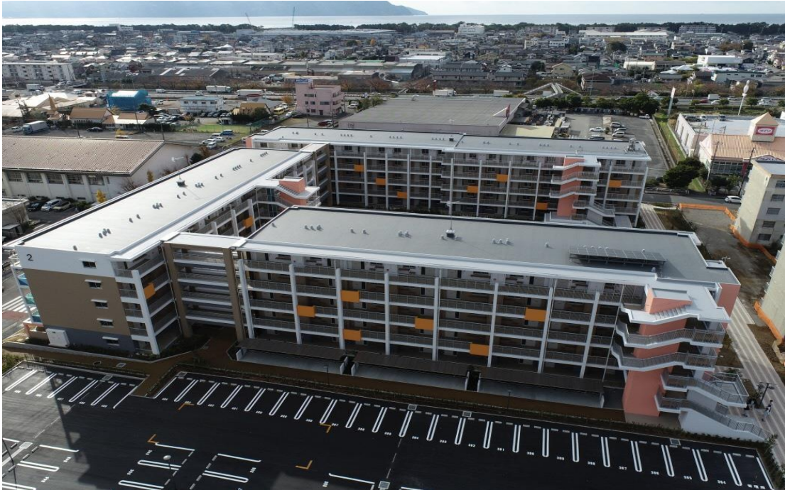
【写真】建物外観
