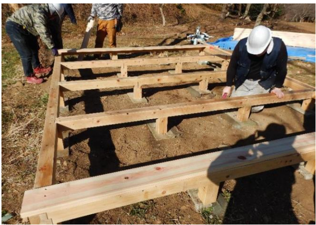
【写真】 土台部分の状況
