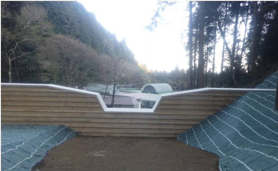
【写真】 上流残存型枠
