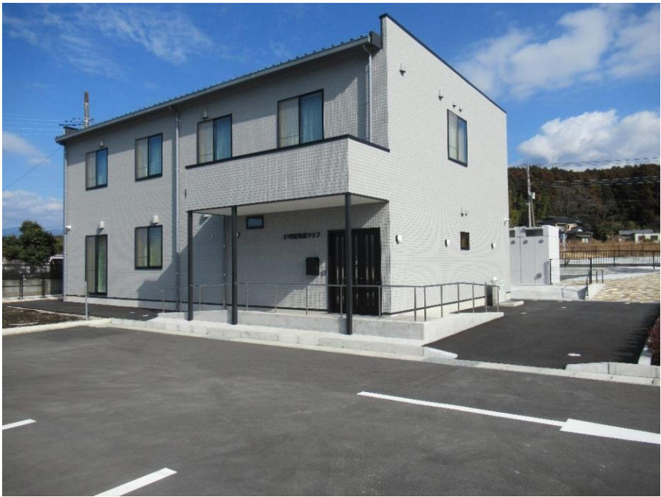
【写真】建物外観
