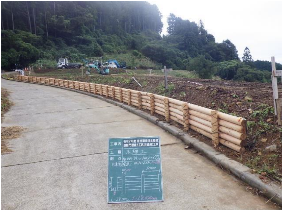
【写真】 完成状況
