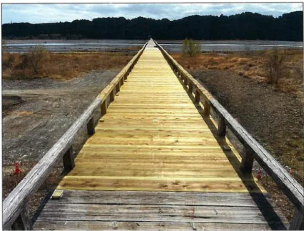
【写真】上部工（束柱・笠木・敷板）
