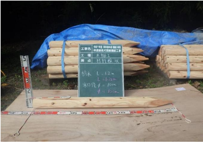
【近景】使用材料(杭木)
