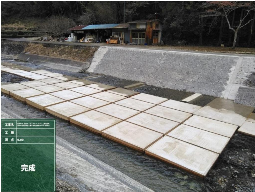
【写真】 根固工完成
