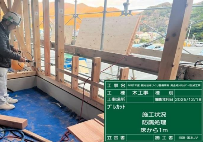
【写真】 プレカット施工状況
