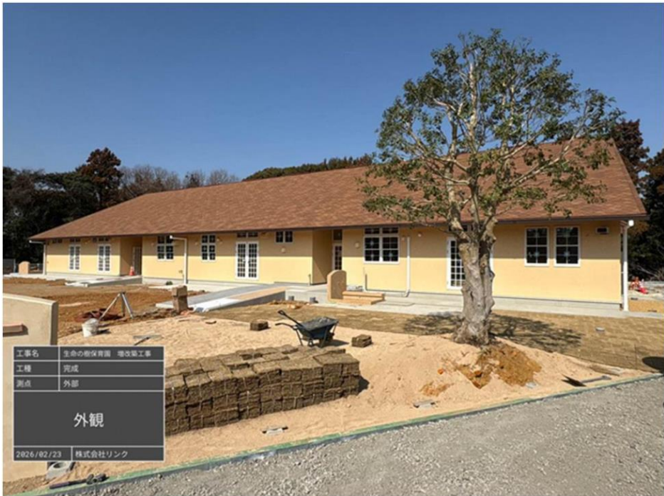
【写真】 建物外観
