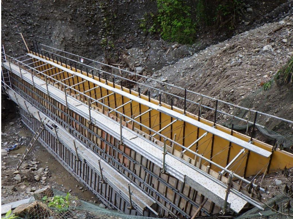
【写真】 型枠全景
