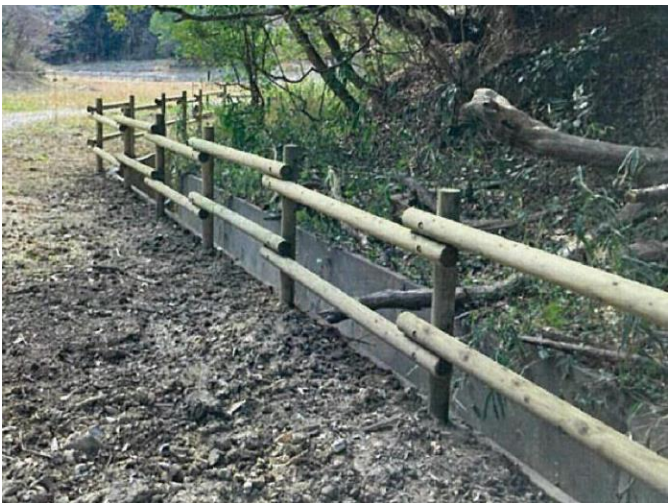
【写真】 転落防止柵設置状況
