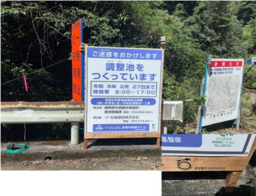
【写真】 工事看板
