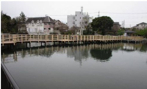
丸池連絡橋（駿東郡清水町） 木橋
