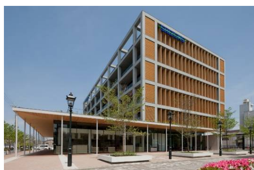
第1回ふじのくに木使い建築施設表彰 優秀賞 静岡ガス株式会社ビル(静岡市駿河区)
