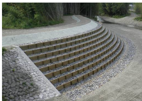
河川事業（浜松市天竜区） 加工丸太を利用した木製護岸工
