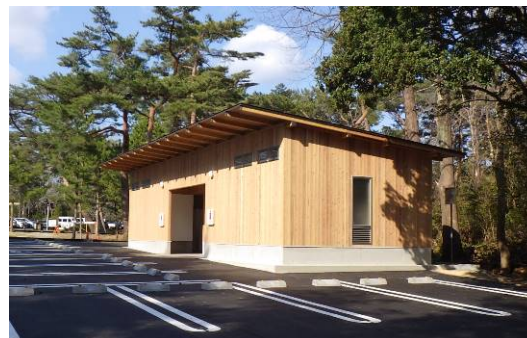
県立森林公園中央公園トイレ（浜松市浜北区） 初めてCLTを活用した県有施設
