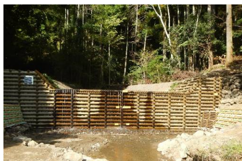
治山事業（静岡市清水区） 加工丸太を利用した谷止工
