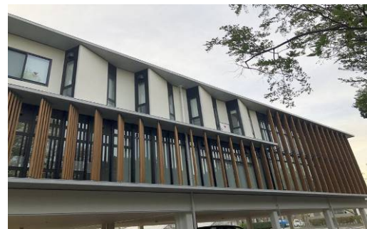
農林環境専門職大学（磐田市） 外部ルーバーに県産材を使用した教育施設
