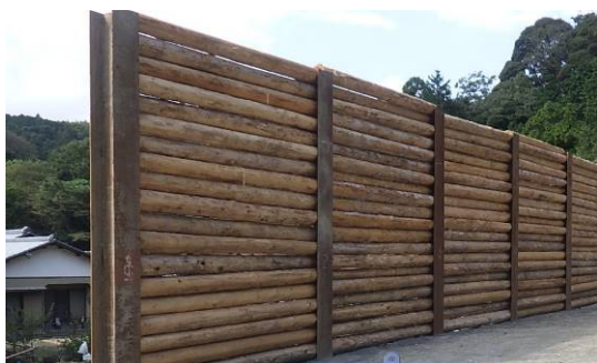
砂防事業（藤枝市） 丸太を利用した仮設工
