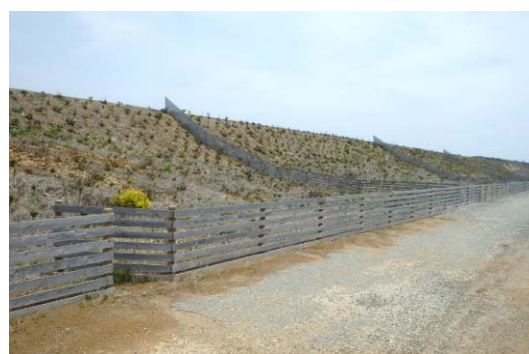
防潮堤整備事業（浜松市南区） 製材品(板)を利用した木柵工
