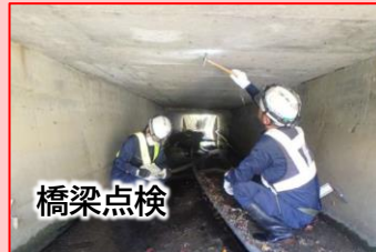
国道150号（小出橋）
