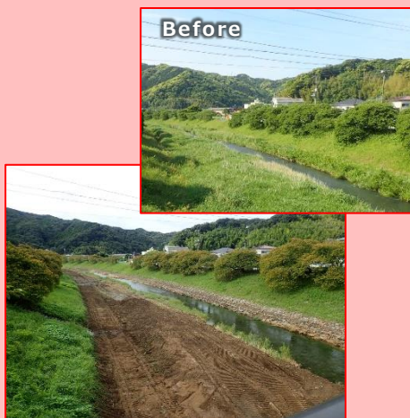
堆積土砂の掘削
