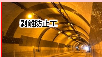
県道伊東修善寺線（冷川トンネル）
