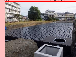
雨水貯留施設の整備
