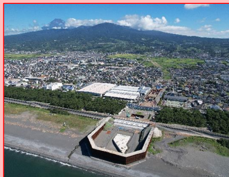
放水路の整備
