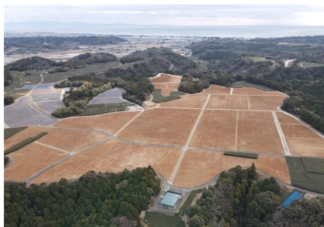
完成(令和5年度工事完了・植栽)
