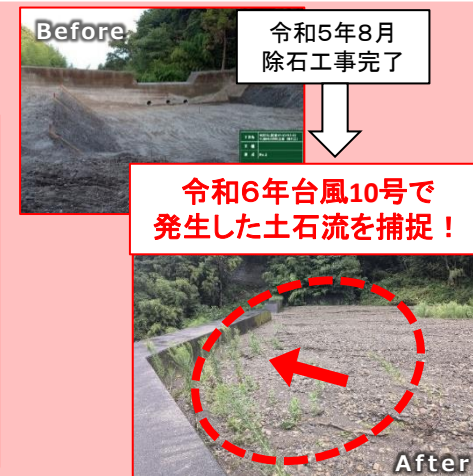
砂防堰堤の除石効果
