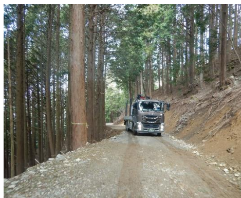
<基幹的作業道〔浜松市天竜区〕>
