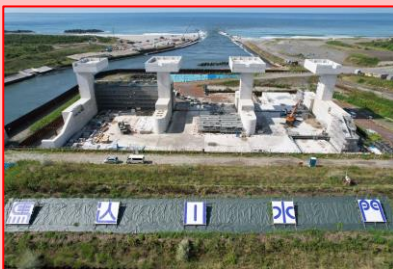
津波対策水門の整備
