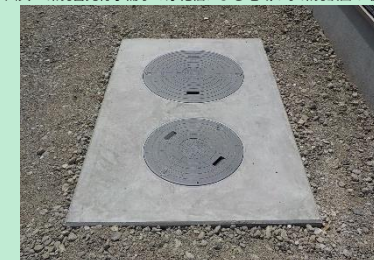
合併浄化槽の設置
