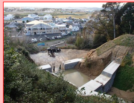
砂防堰堤の整備※R6完成見込
