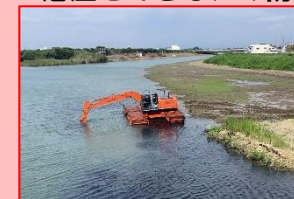
河川改修の実施
