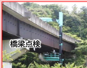
国道473号（子生れ橋）
