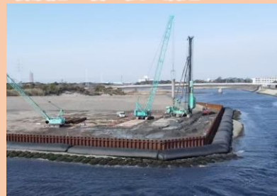
馬込川水門 仮締切工
