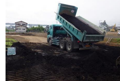
(乙) 圃場整備工事
