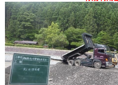
(乙) 令和5年度 [第35-B3541-01号] 大井川支川川根長尾川5年砂防災害復旧工事5年災害査定第167号 (応急工事)
