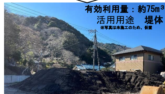
(乙) 急傾斜地崩壊対策工事
