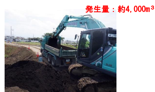
活用用途 (基盤整地) (甲) 土留築造工事
