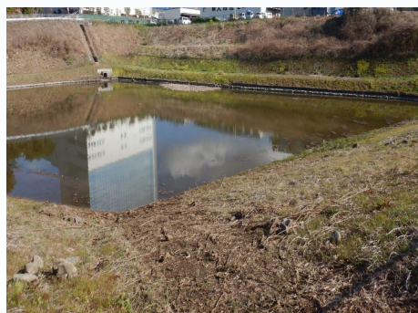
尾羽1号調整池
