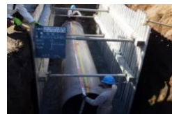
農業用水管改修（裾野市）
