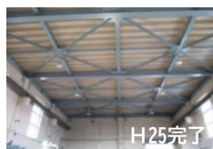
H25完了 排水機場（建屋）の補強 (伊豆の国市堂川地区)
