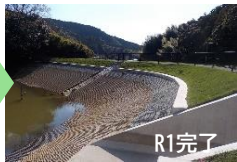
ため池の耐震補強（島田市大谷池地区）
