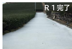
農作業道の舗装 （牧之原市相良地区）
