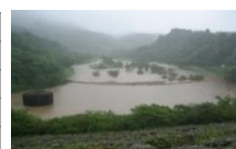
洪水時の 大倉川農地防災ダム
