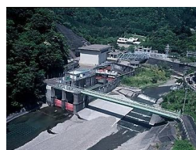
大井川用水（川口取水工）
