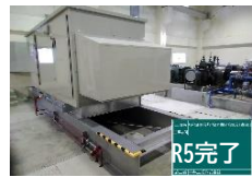
R5完了 非常用発電装置の整備 (函南町落合排水機場保全災害地区)
