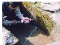
ひび割れの補修
