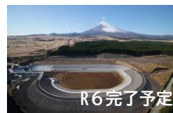
境沢川調節池（御殿場市）
