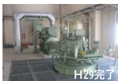
H29完了 排水機場の増設 (伊豆の国市毘沙門2期)
