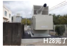
H28完了 非常用発電装置の更新 (函南町畑毛排水機場地区)
