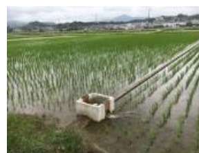
用水のパイプライン化 （浜松市中川地区）
