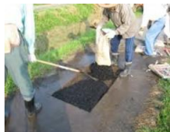
農道の部分補修
