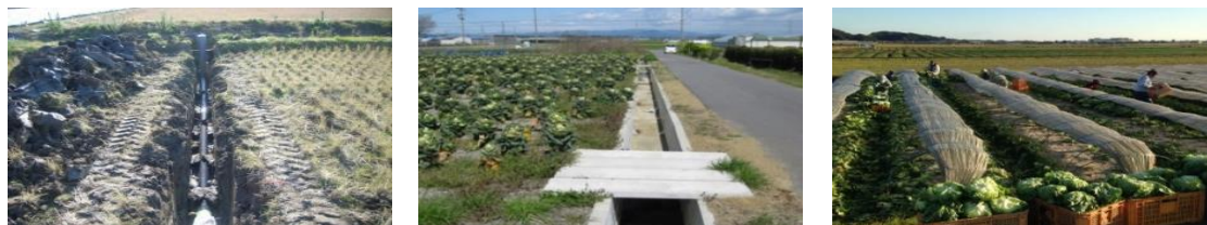
水田汎用化による高収益作物導入のイメージ （左：排水路整備 中央：暗渠排水整備 右：高収益作物（レタス）の栽培）
