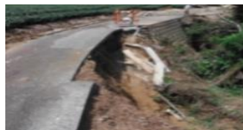
H25完了 崩落した農道法面の復旧(牧之原市谷田地区)
