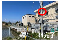
R4完了 Webカメラ設置 (浜松市浜松南部地区)
