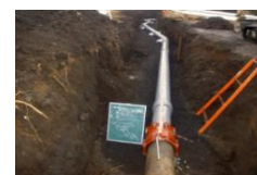
用水管補修（御殿場市）
