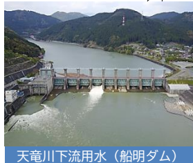
天竜川下流用水（船明ダム）
