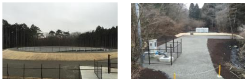
高根調整池 (御殿場市) 水源揚水井戸 (御殿場市)
