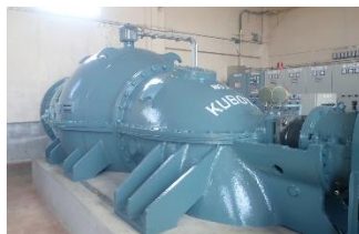
排水機場ポンプの補修
