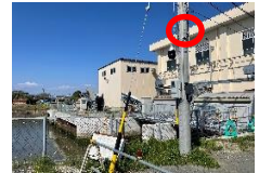
Webカメラ設置 (浜松市浜松南部地区)
