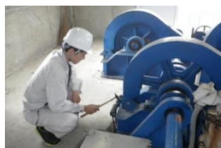
頭首ゲート点検 （浜松市浜名湖北部地区）
