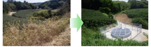
集水井の整備 (御前崎市横舟地区)
