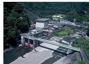
大井川用水（川口取水工）
