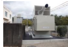
非常用発電装置の更新 (函南町畑毛排水機場地区)
