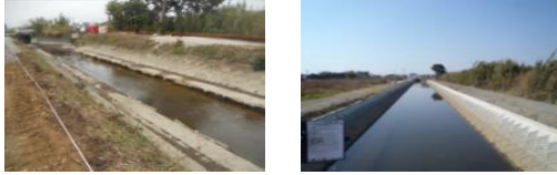
排水路の改修 (浜松市米津排水路地区)
