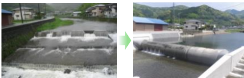
取水堰の改修 (松崎町岩科松尾地区)
