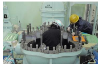
ポンプ点検補修 （島田市他4市牧之原地区）
