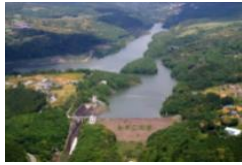
防災ダムの整備 (浜松市都田川ダム地区)
