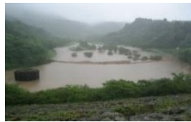
洪水時の 大倉川農地防災ダム
