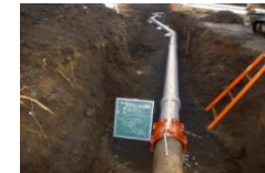
用水管補修 (御殿場市)
