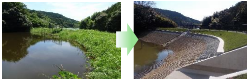
ため池の耐震補強 (島田市大谷池地区)
