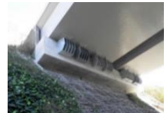
排水路の補強 (浜松市段子川排水路地区)
