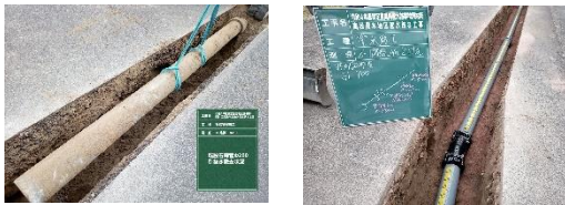
石綿管撤去 (御前崎市高松用水地区)
