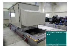
非常用発電装置の整備 (函南町落合排水機場保全災害管地区)
