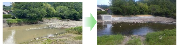
被災した頭首工護岸の復旧 (掛川市大和田地区)
