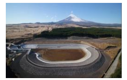
境沢川調整池 (御殿場市)
