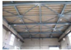
排水機場(建屋)の補強 (伊豆の国市堂川地区)
