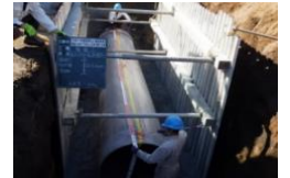
農業用水管改修 (裾野市)
