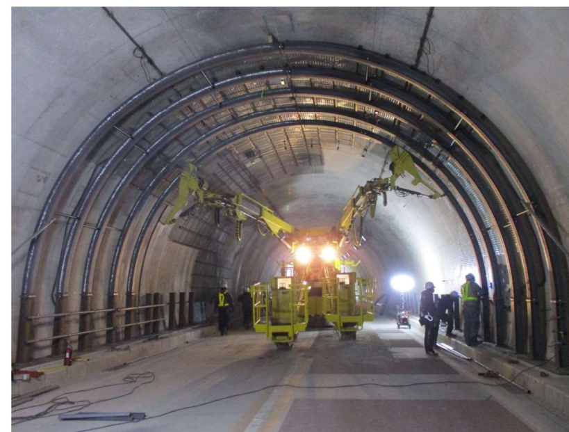
国道152号秋葉トンネル(浜松市)施工事例
