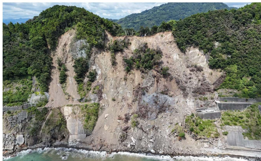
斜面崩壊全景（R6.9.4撮影）
