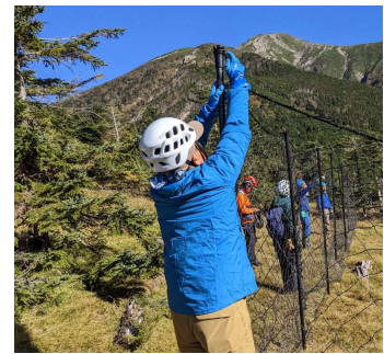
防鹿柵立上げ作業
