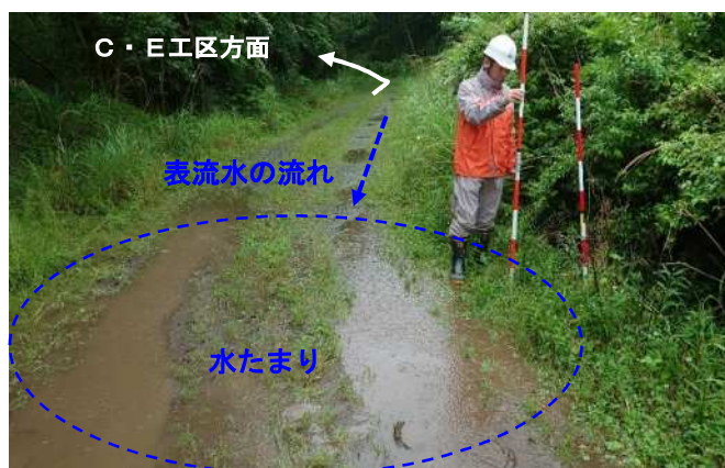
道路が E 工区から D 工区に向かって下り勾配になっており、D 工区内に水たまりができている
