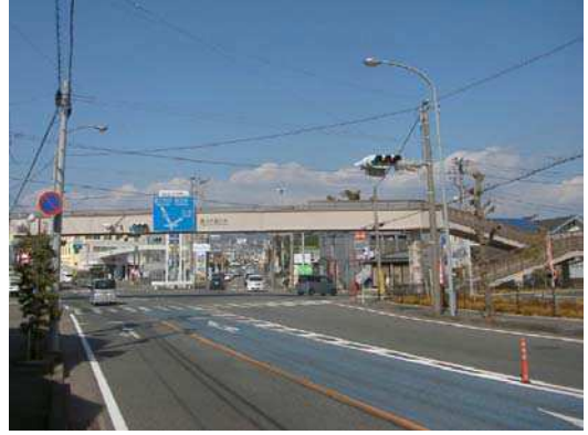
(国道1号 青島横断歩道橋)
