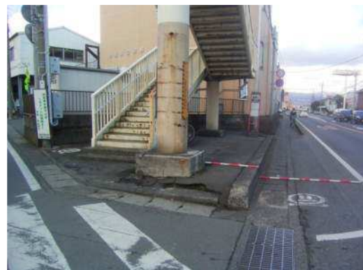
写真 4-2 歩道が狭くなっている事例
