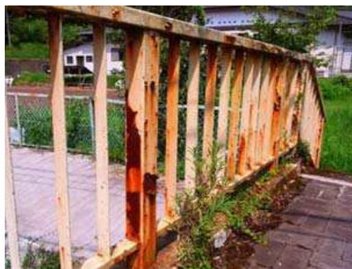
写真 4-4 高欄の腐食
