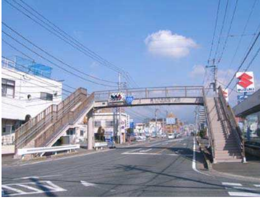
(国道1号 国久保横断歩道橋)
