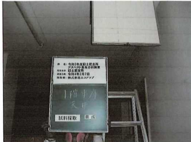
写真-1 1階車庫天井 石綿ケイ酸カルシウム板 試料採取箇所
