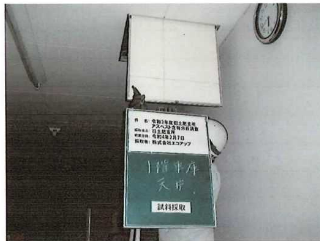
写真-2 1階車庫天井 石綿ケイ酸カルシウム板 試料採取
