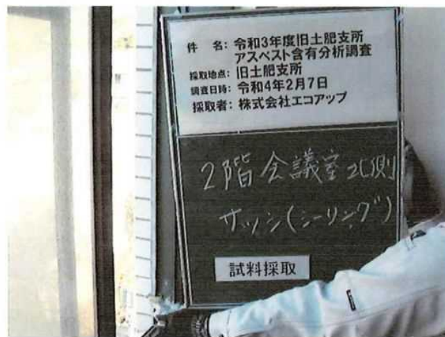
写真-2 2階会議室 サッシ(シーリング) 試料採取
