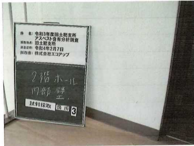
写真-7 2 階ホール内部壁 吹付タイル 試料採取箇所 3
