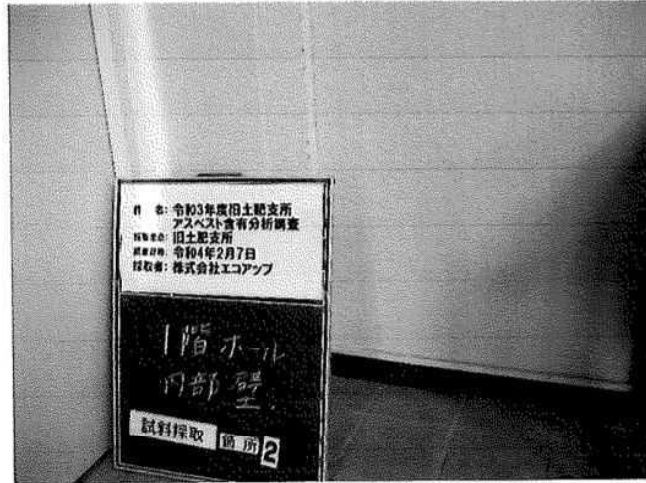
写真-4 1 階ホール内部壁 吹付タイル 試料採取箇所 2
