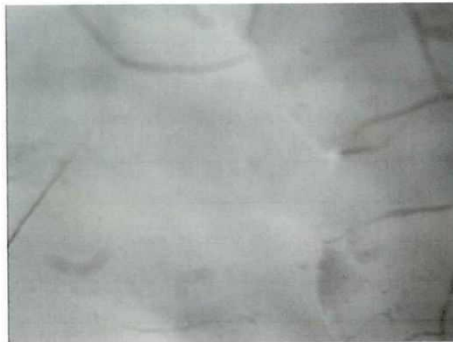
写真・11 階段内部壁 吹付タイル 顕微鏡視野：10 倍
