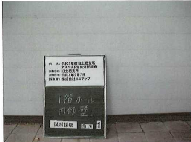
写真-1 1 階ホール内部壁 吹付タイル 試料採取箇所 1
