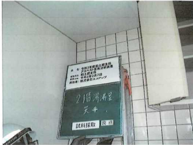
写真-1 2階湯沸室天井 石綿ケイ酸カルシウム板 試料採取箇所
