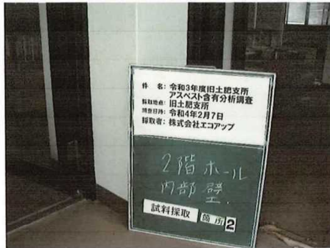
写真-4 2階ホール内部壁 吹付タイル 試料採取箇所 2
