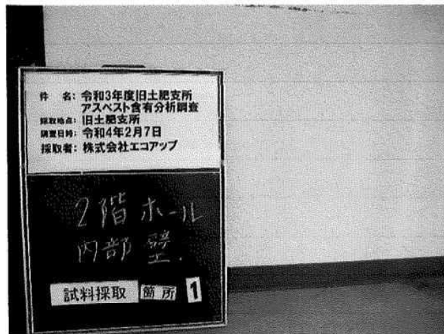
写真-1 2階ホール内部壁 吹付タイル 試料採取箇所 1
