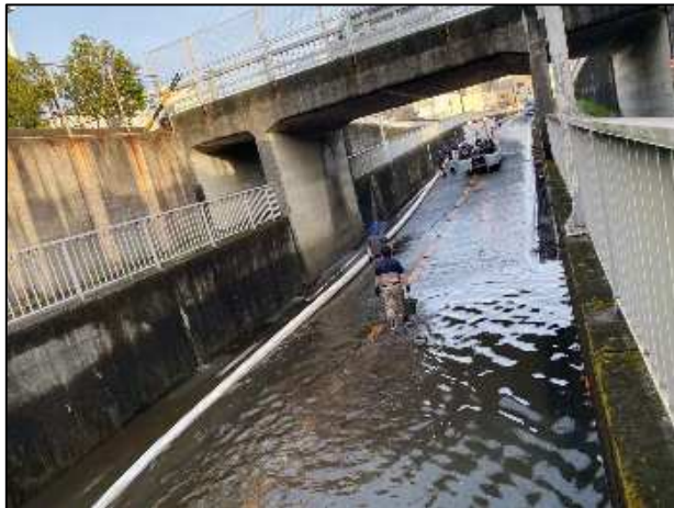
焼津市中港地下道 排水作業
