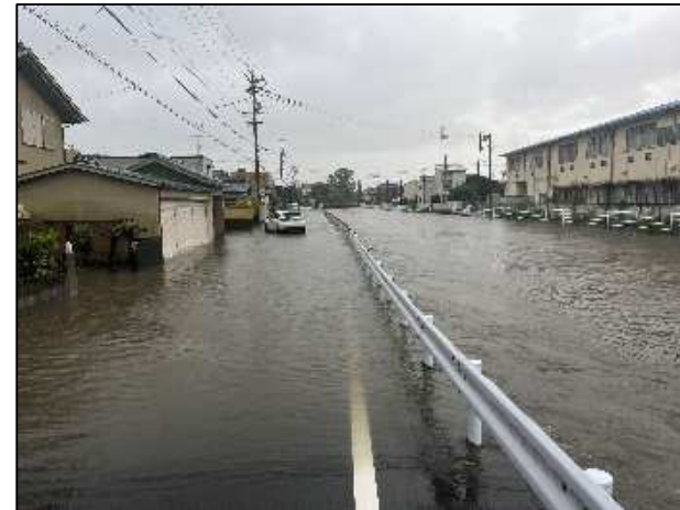
二級河川小石川 溢水被害 （焼津市栄町6丁目 地先）
