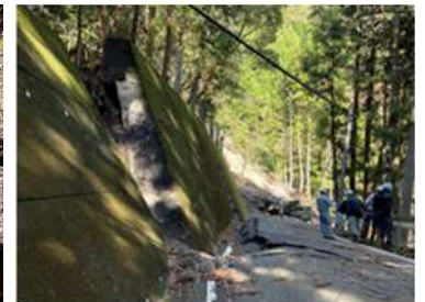
②擁壁の押出し
