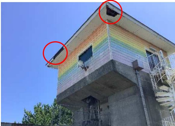
栃山川水門(焼津市)
