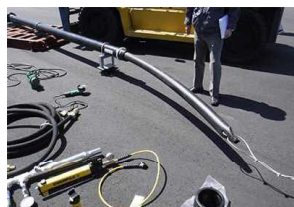
更生材引込挿入
