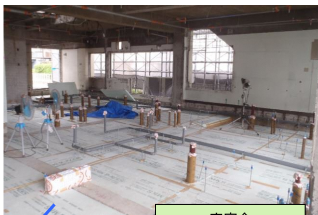
寄宿舍 (厨房床下配管工事)
