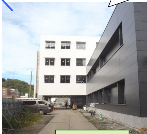
敷地内南西側
