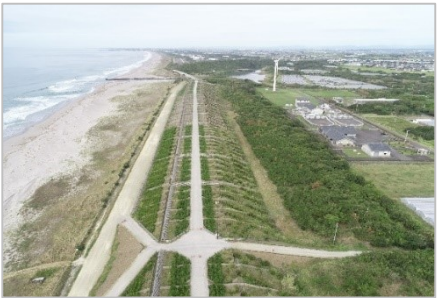
森の防潮堤(掛川市)
