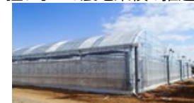
園芸用鉄骨ハウス整備への補助
