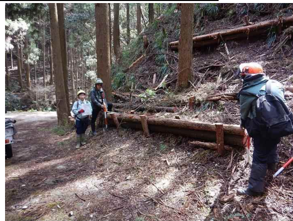
簡易作業路(簡易木製構造物)
