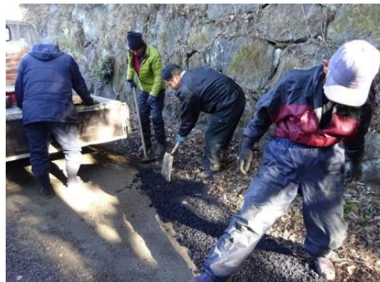
農道のアスファルト補修
