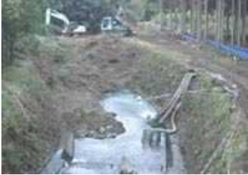
埋塞土砂の撤去（数沢川）
