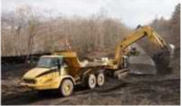
堆積土砂の撤去（ふじあざみライン）
