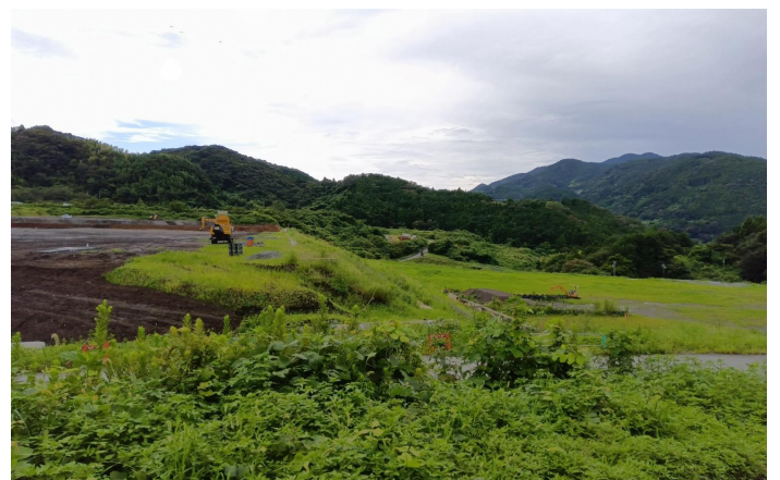
建設発生土の最終処分場（富士市）
