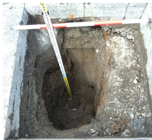
下水道管状況確認(損傷無し)
