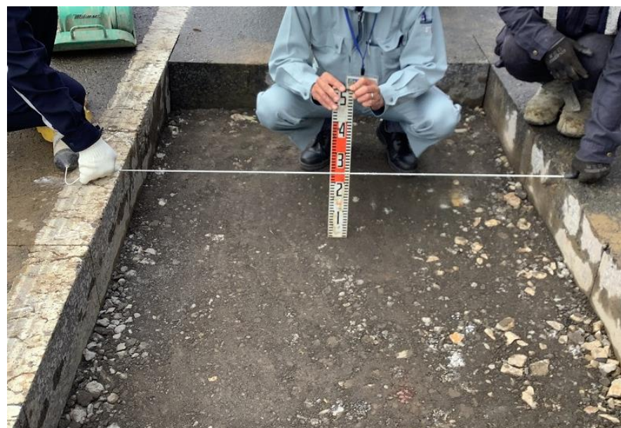
《碎石材充填完了》
