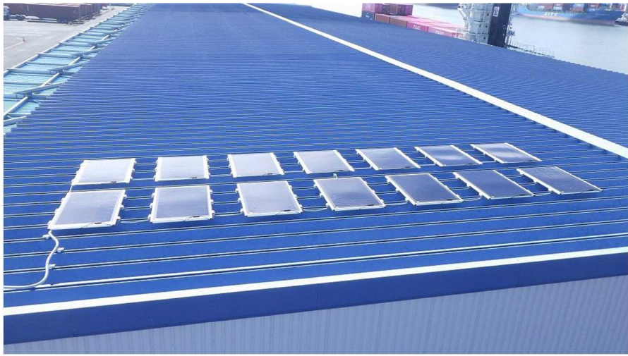
フィルム型ペロブスカイト太陽電池導入実証 画像提供：積水化学工業株式会社
