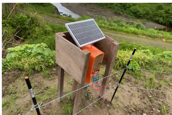
電気柵設置状況
