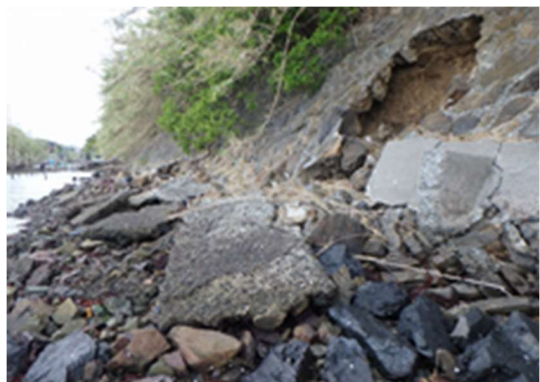
図 3.5 老朽化した湖岸堤
